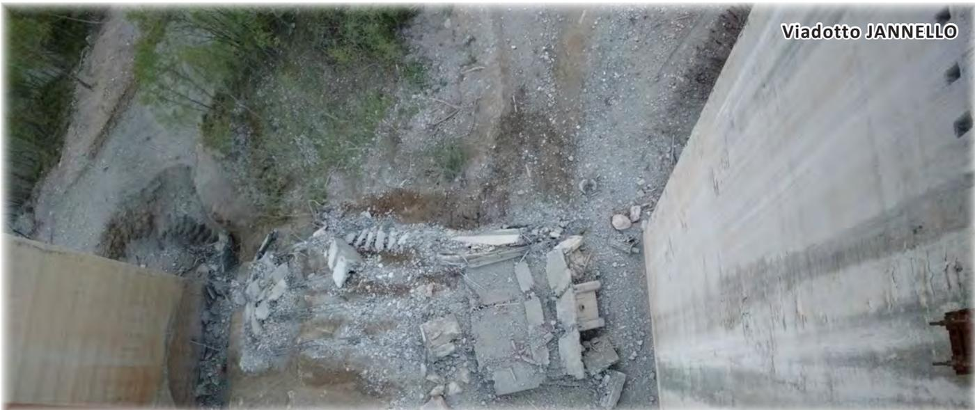
Impalcati del viadotto JANNELLO e del viadotto ITALIA al suolo, abbattuti con esplosivo mantenendo integre le pile che saranno destinate a supportare la nuova sovrastruttura (altezza di caduta rispettivamente max +135 metri e max +120 m a zero)
