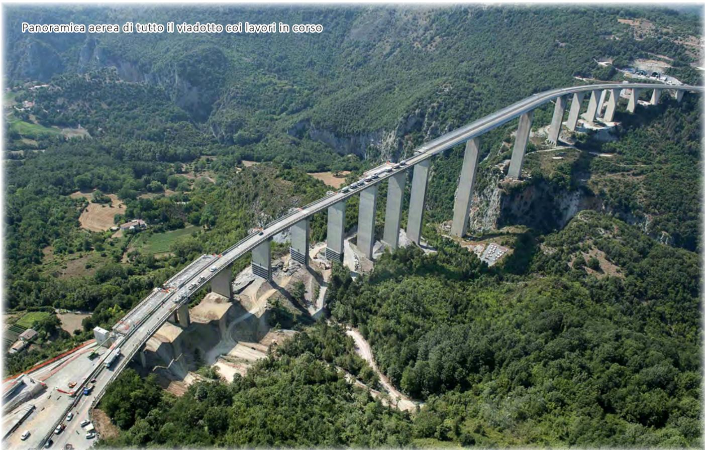
Lavori in corso per la costruzione delle nuove sovrastrutture dall'imbocco Sud della galleria. Il traffico di entrambe le direzioni di marcia è ancora deviato sulla vecchia carreggiata Nord, mentre la carreggiata Sud è già stata demolita.
