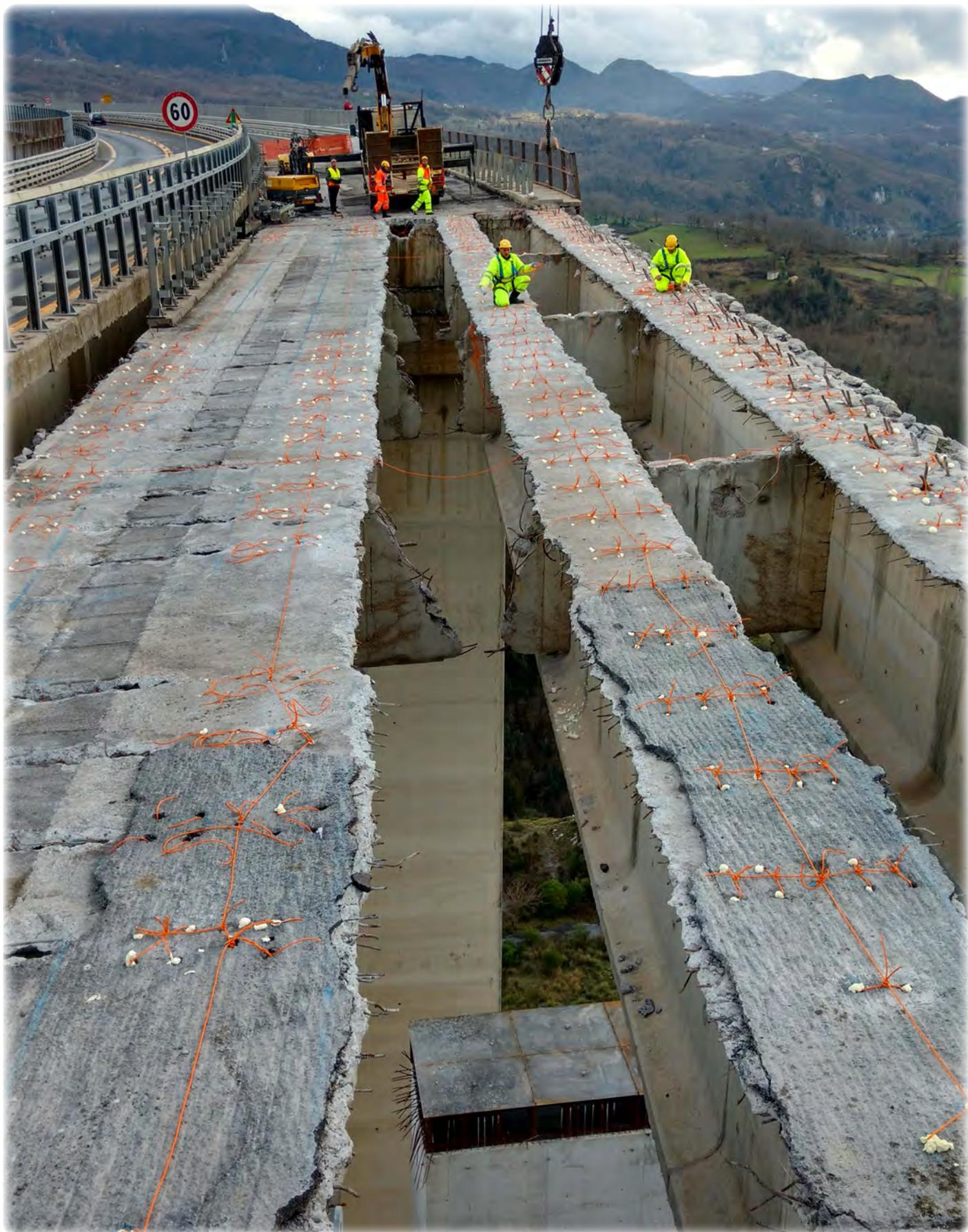
Impalcato della carreggiata Sud in fase di caricamento esplosivi. È visibile la nuova pila sottostante, costruita a mezz'altezza, con una protezione in acciaio in testa. Al lato la carreggiata Nord, vecchia sovrastruttura, sulla quale era stato deviato il traffico di entrambe le direzioni
