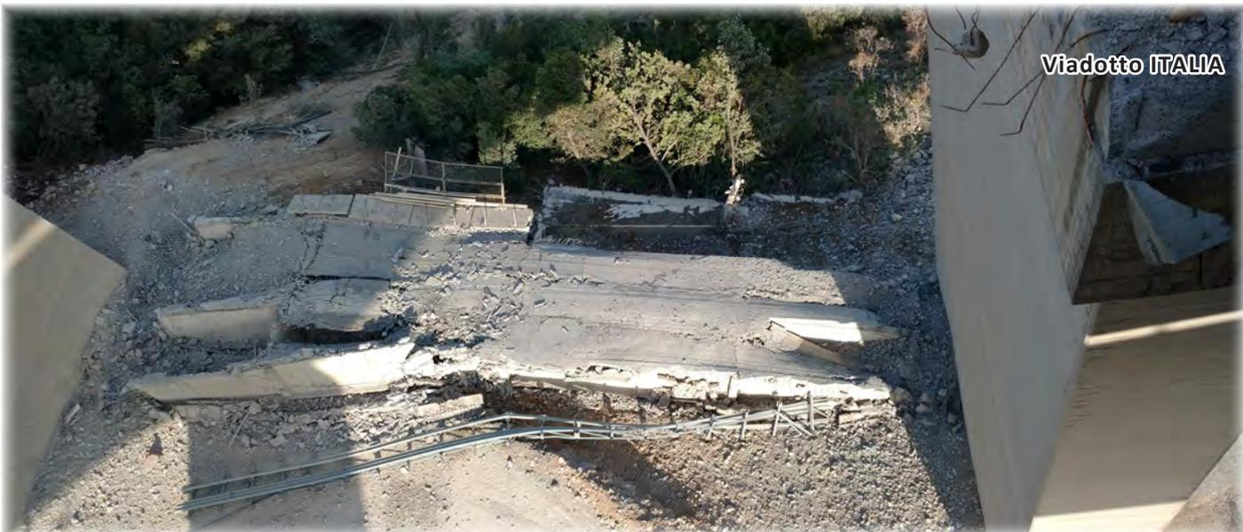
Impalcati e pile al suolo, abbattuti per la demolizione integrale (da max +60 metri a zero)
