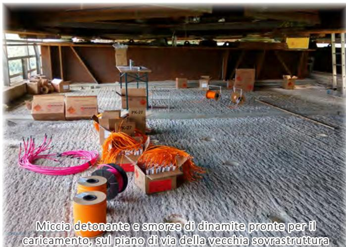
Miccia detonante e smorze di dinamite pronte per il caricamento, sul piano di via della vecchia sovrastruttura
