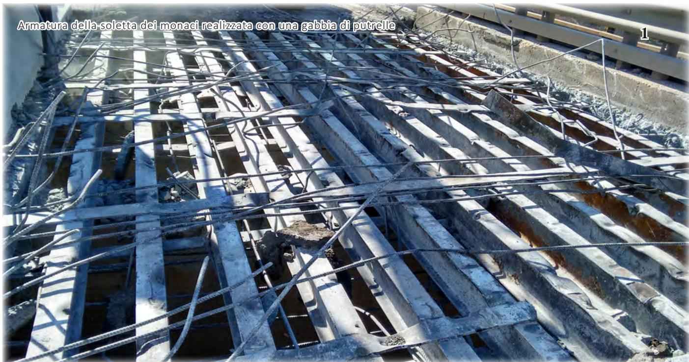
Demolizione del monaco e della soletta del pulvino, con esposizione delle nervature, per la predisposizione al completamento del nuovo pulvino per la nuova sovrastruttura
