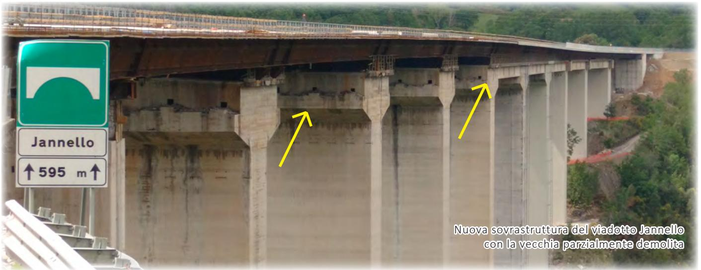
Nuova sovrastruttura del viadotto Jannello con la vecchia parzialmente demolita
