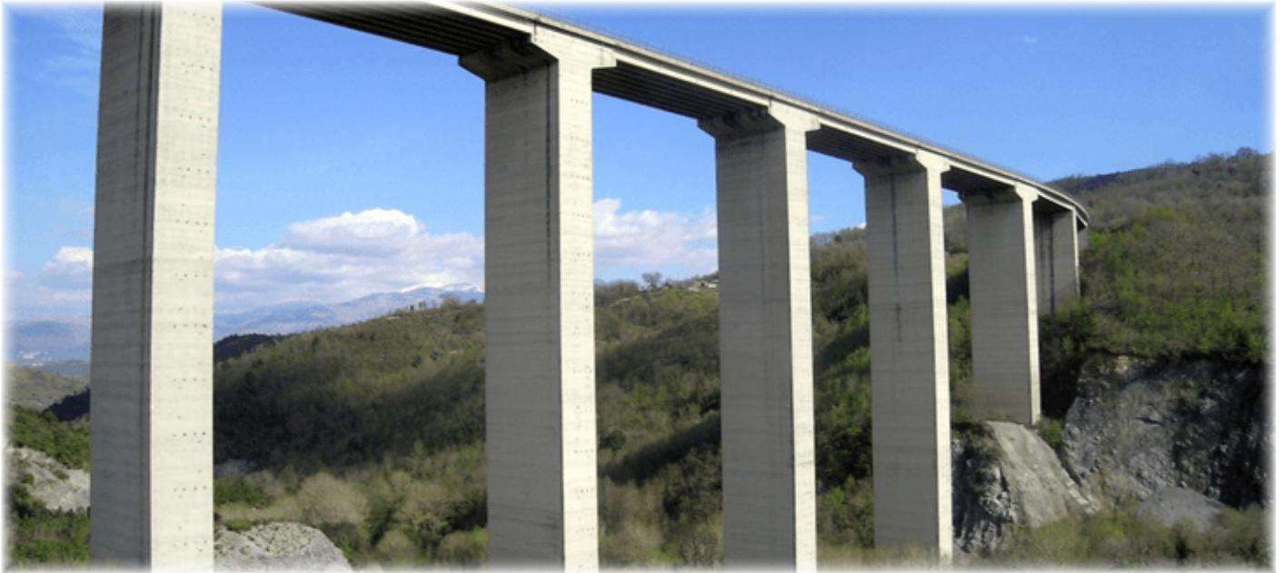
La demolizione del vecchio viadotto Jannello fu prevista per i soli impalcati, con preliminare abbattimento e salvaguardia dell'integrità strutturale e funzionale delle pile (scatolari ad una stilata, sez. rettangolare, unica per entrambe le carreggiate).
