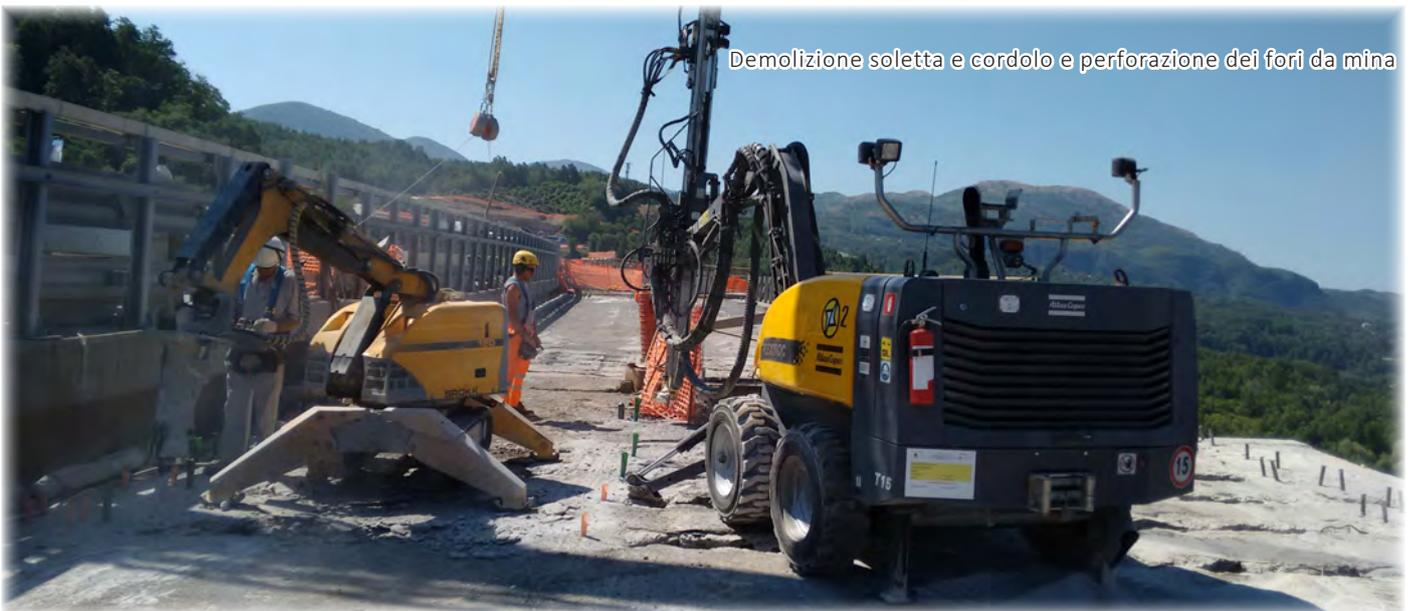
Demolizione soletta e cordolo e perforazione dei fori da mina
