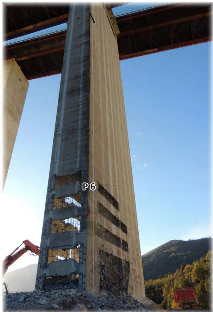
Apertura forometrie e perforazione fori da mina sulle pareti di base della pila 5 per la realizzazione del cuneo di ribaltamento
