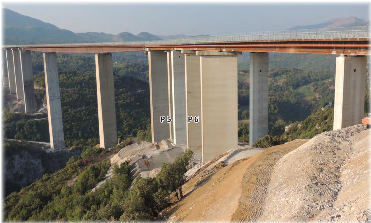
Foto delle vecchie pile 5 e 6 rimaste sotto il nuovo impalcato, a 20 cm dalla piattabanda
