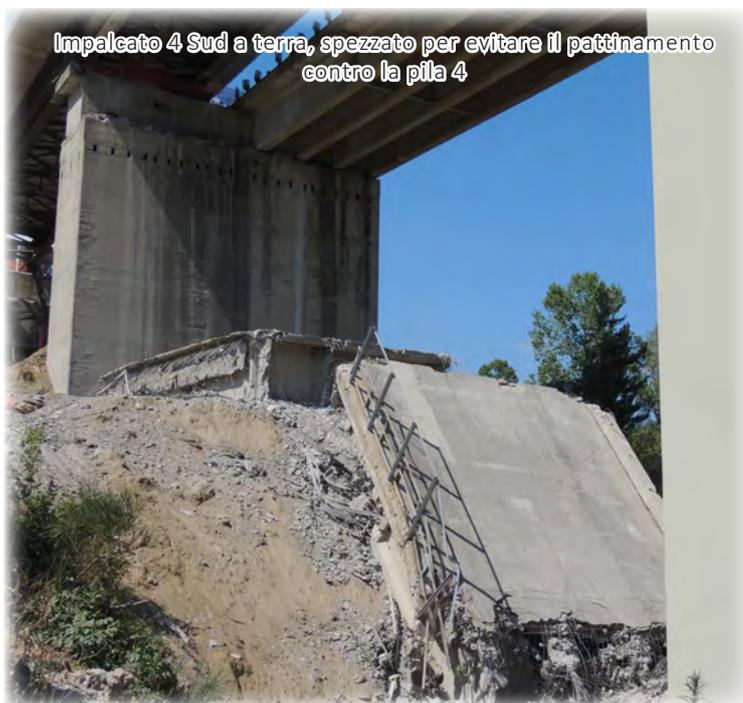
Impalcato 4 Sud a terra, spezzato per evitare il pattinamento contro la pila 4
