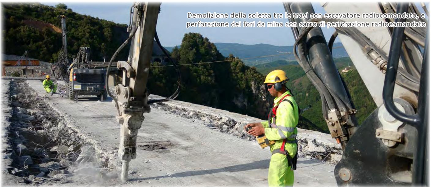
Demolizione della soletta tra le travi con escavatore radiocomandato, e perforazione dei fori da mina con carro di perforazione radiocomandato
