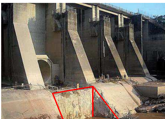
demolizione parziale in diga per l'alloggio di un'opera di presa
