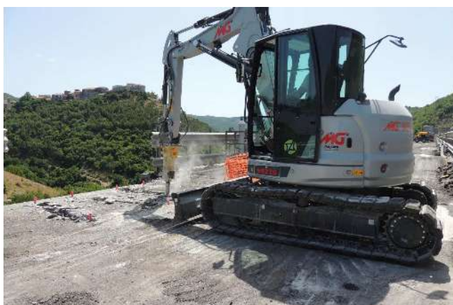
demolizione meccanica preliminare, di precisione
