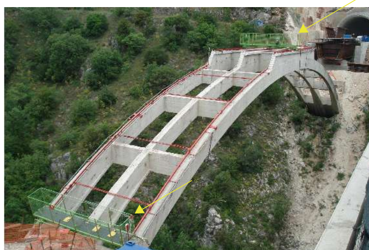
ponte ad arco sistema Melan (traliccio in ferro incorporata nel calcestruzzo armato), altezza massima 150m, accesso tramite piattaforma idraulica FALABELLA, auto progettata e costruita
