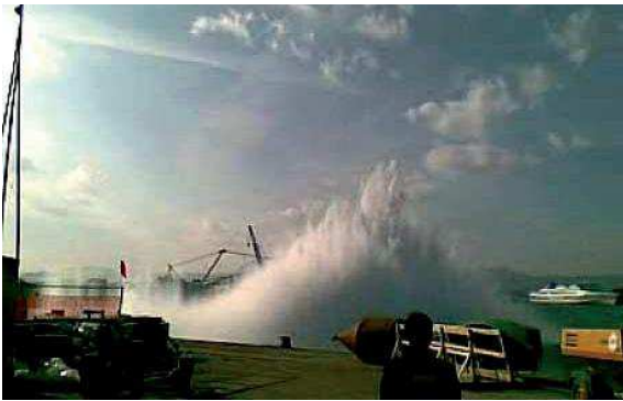
cariche esplosive subacquee per l'abbattimento subacqueo con battente ridotto, vicino al molo
