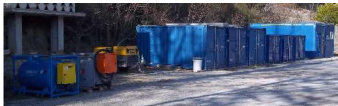
magazzini di cantiere
