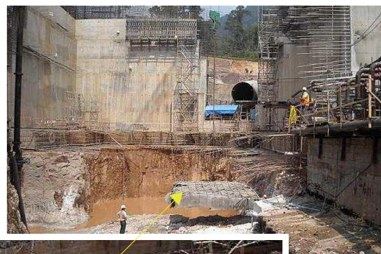
confinamento del 100% dei frammenti di roccia grazie all'utilizzo di reti di funi d'acciaio
