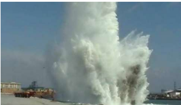
cariche sagomate di composizione A5 per la demolizione del calcestruzzo armato
