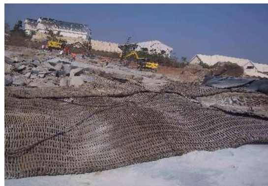
confinamento del 100% dei frammenti di roccia grazie all'utilizzo di reti di funi d'acciaio
