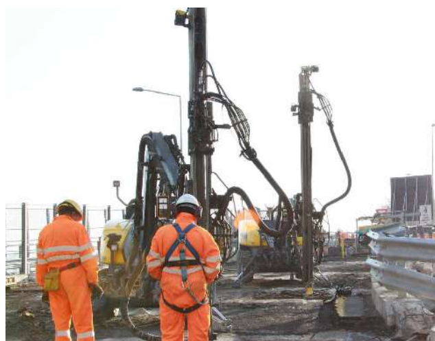
carri di perforazione idraulici, radio comandati
