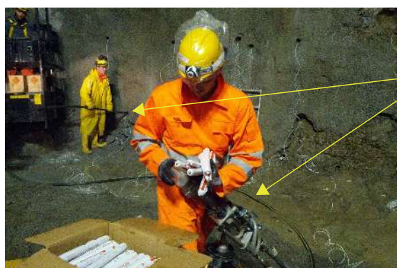
caricamento pneumatico
