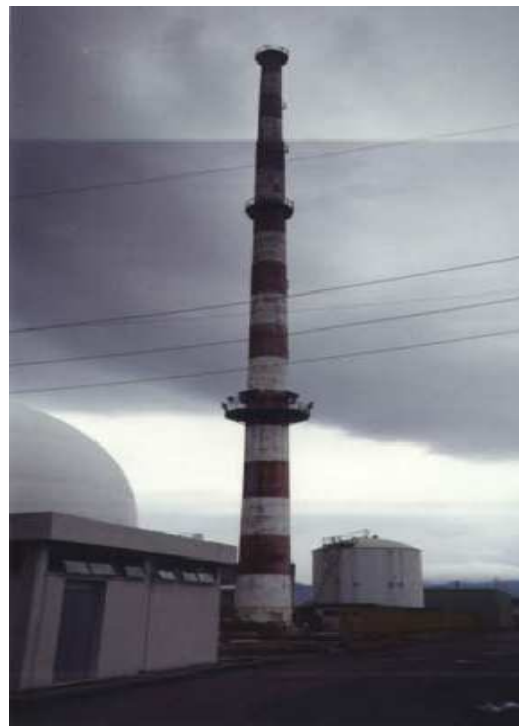
camino di ventilazione di una centrale nucleare, bonifica preliminare dei volumi interni contaminati prima dell'abbattimento
