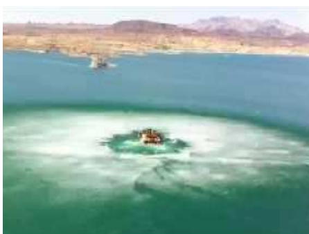
impronta dell'onda d'urto sul piano dell'acqua, a seguito di brillamento con cariche cave alla profondità di 100 metri
