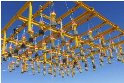
cariche appese al telaio di posa
