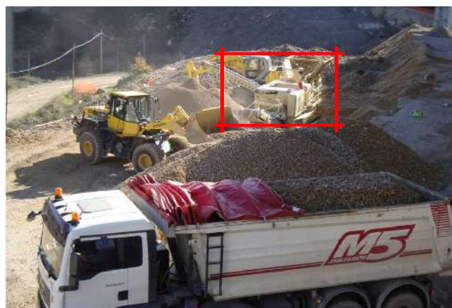
sito di demolizione con frantoio mobile
