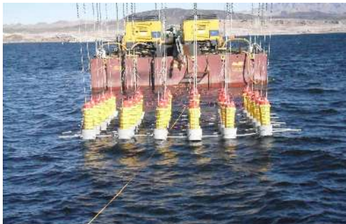
cariche appese al telaio di posa
