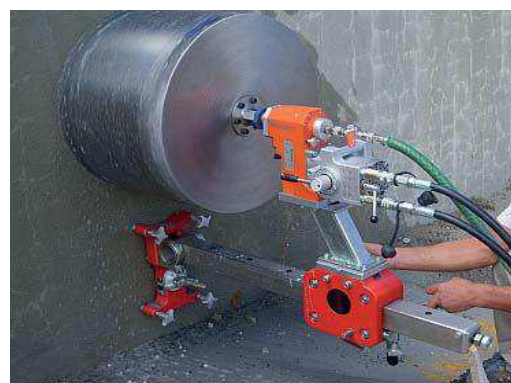
realizzazione di passo d'uomo con carotaggio di grande diametro
