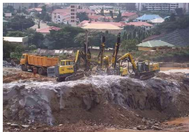
varietà di contesti geologici in uno scavo stradale in trincea
