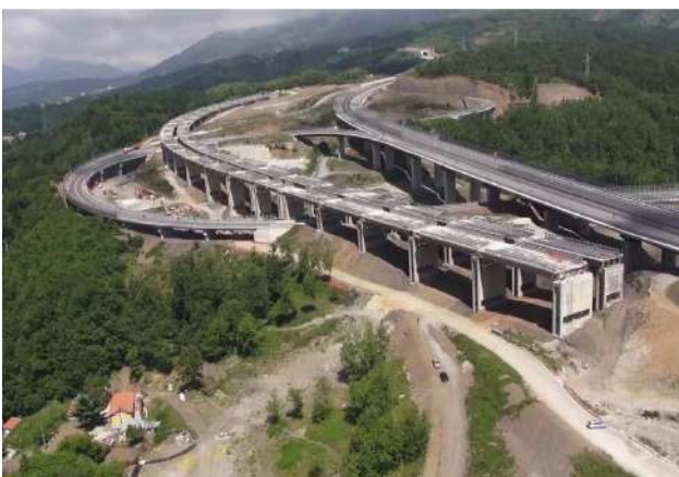
ponte lungo 1 km, 44 impalcati. . .
