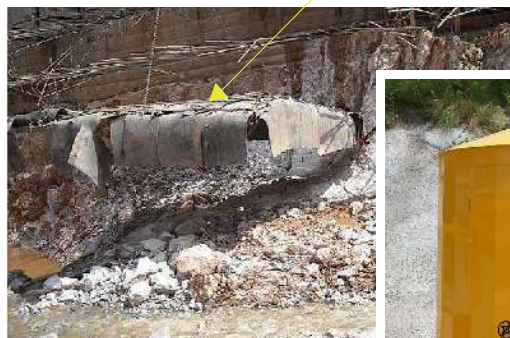
progettazione autonoma, dispositivo di contenimento lancio e sfogo gas d'esplosione, realizzato con teli rinforzati di nastro trasportatore
