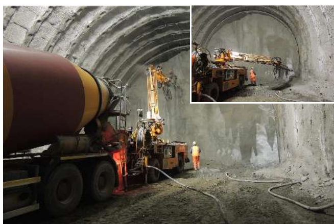
calcestruzzo proiettato, sistema di controllo basato su laser
