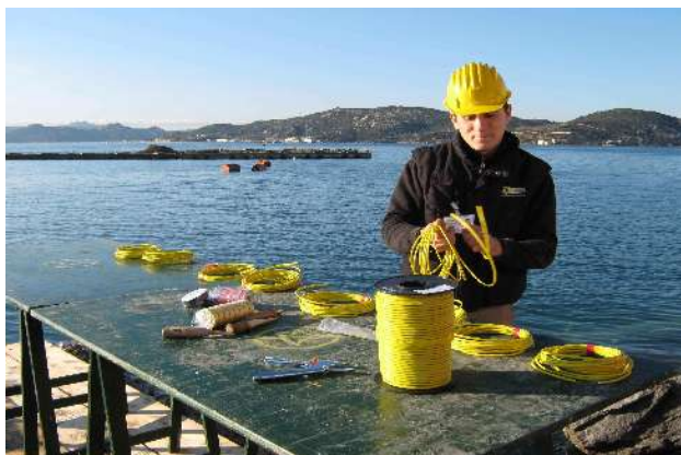
preparazione di un'esplosione, sparo e rimozione dei segmenti di calcestruzzo armato altamente rinforzato demolito con cariche sagomate vicino il molo
