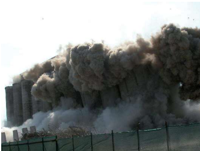
abbattimento dei silos con cariche esplosive nelle intercelle riempite d'acqua, 20 silo in un'unica volata. PRIMA ESECUZIONE A LIVELLO MONDIALE
