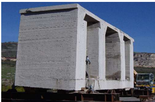
tagli con utensili diamantati per la decostruzione
