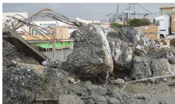
fondazioni di cassoni autoaffondanti, in calcestruzzo fortemente armato, sezionate mediante l'uso di cariche cave di composizione A5
