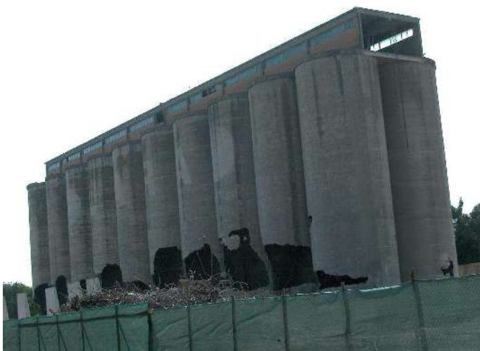
apertura di finestre – NESSUNA PERFORAZIONE DI FORI DA MINA
