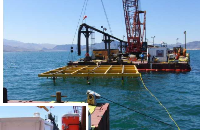
pontone, in fase di salpamento del telaio di posa cariche cave
