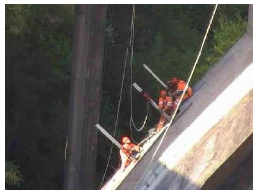
perforazione preliminare per la demolizione di un ponte ad arco
