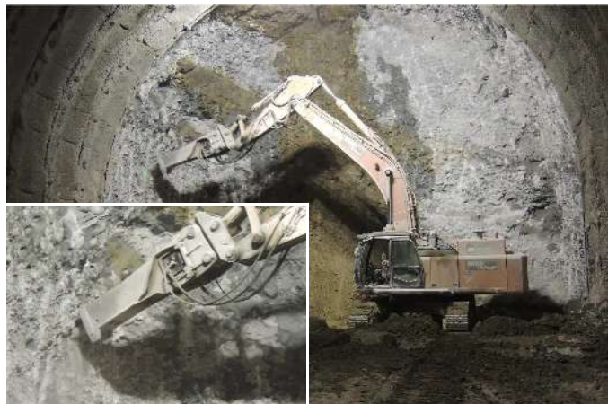
scavo per mezzo di un martello idraulico
