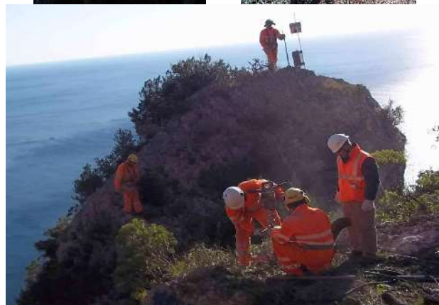
stazioni di monitoraggio ad accesso in remoto, in fase di installazione
