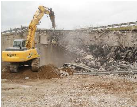
sequenza di demolizione meccanica a terra
