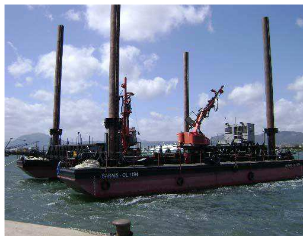
jack-up attrezzato con guide per la perforazione con due carri OD
