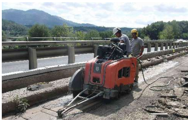
tagli preliminari con utensili diamantati, di lastre
