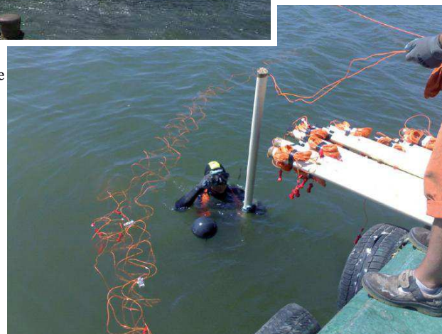
precariche di composizione B, per la perforazione e brillamento in acque poco profonde
