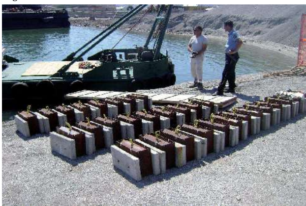
cariche sagomate di composizione A5 per la demolizione del calcestruzzo armato
