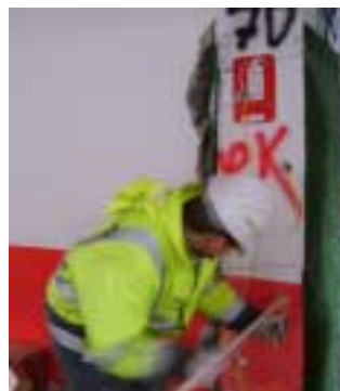
Caricamento di un pilastro (40x40 cm), 5 fori da mina
