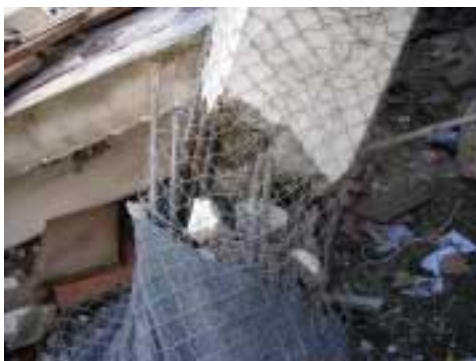
Pilastro (40x40) con 2 fori da mina, caricati con dinamite gelatina 70 grammi/foro. Si nota la doppia armatura fra quello del pilastro e le chiamate del plinto
