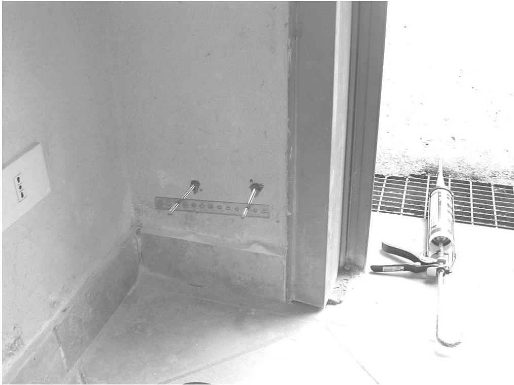
Inghisaggio di due barre filettate sulla parete portante in c.a. di struttura per l'accoppiamento del trasduttore.
