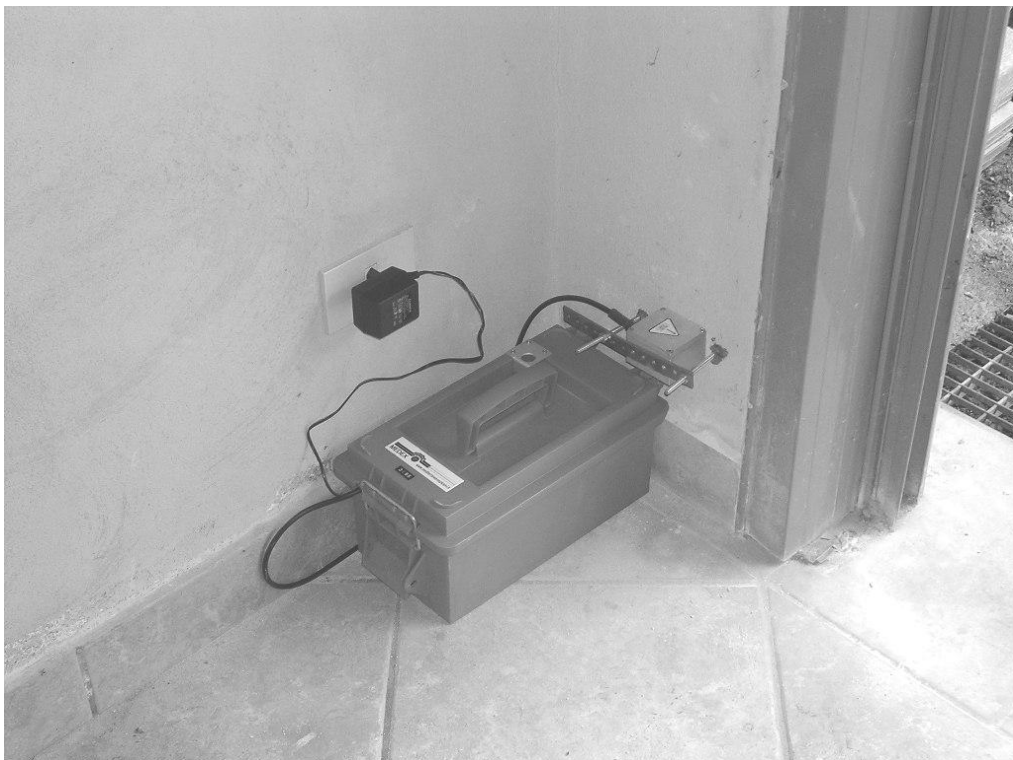
Completamento della stazione di misura con geofono accoppiato a parete con barre filettate e stazione di monitoraggio entro il suo contenitore, alimentato dalla rete, per il monitoraggio continuativo.
