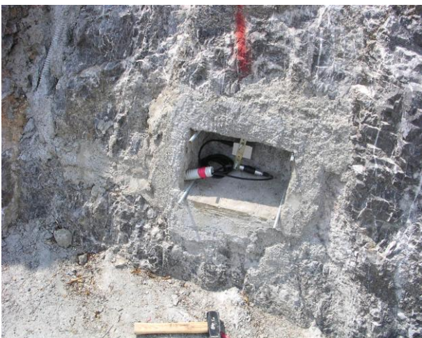
Accoppiamento del trasduttore alla parete rocciosa entro una nicchia mediante barre filettate e piattina preforata. Le barre filettate ai lati esterni della nicchia servono per applicare un coperchio di protezione alla nicchia.
