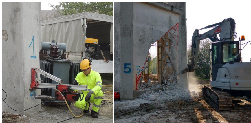
Lavorazioni a base torre, con carotieri e con escavatore radio comandato per l'apertura del cuneo
