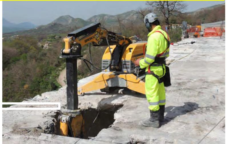
Una volta abbattuti gli impalcati dovevano rimanere stabili sul pendio acclive. Questo per evitare lo scivolamento a valle, con conseguente difficoltà d'accesso per gli escavatori che avrebbero dovuto completare a terra la demolizione.
