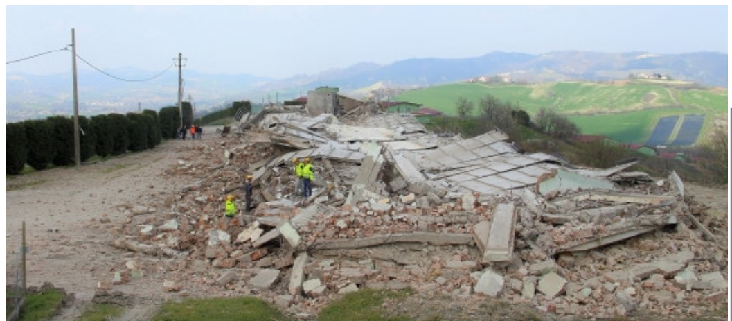
il manufatto a terra dopo l'esplosione, con tutti i muri, i pilastri ed i 6 solai impaccati al suolo, per un'altezza massima dal p.c. di 5 m circa
