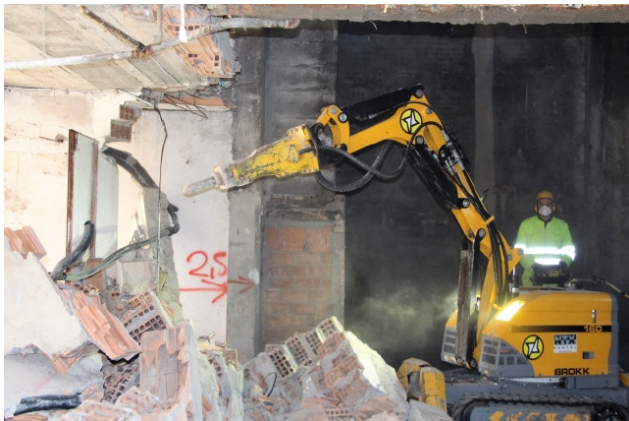
demolizioni preliminari con martello demolitore idraulico su miniescavatore radiocomandato
