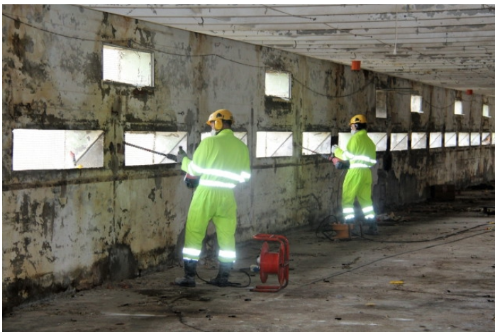
perforazione manuale dei fori da mina
