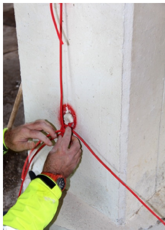
caricamento e collegamento delle cariche esplosive
